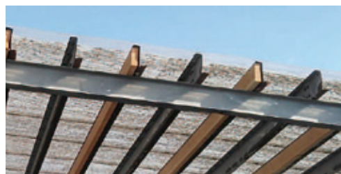
ポリカ波板2重屋根施工
