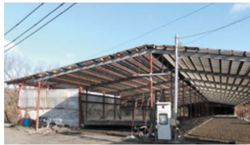
ポリカ波板2重屋根施工
