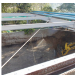
天端錆止め塗布
