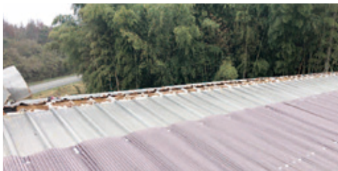
ポリカ波板2重屋根施工
