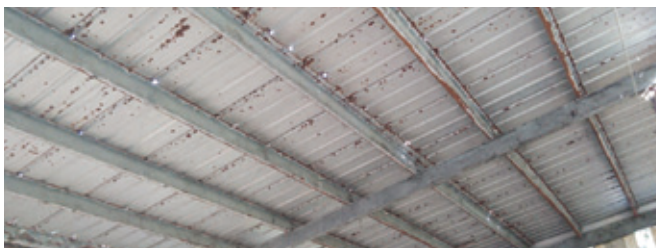
腐食したる所に穴の開いたガルバニウム屋根
