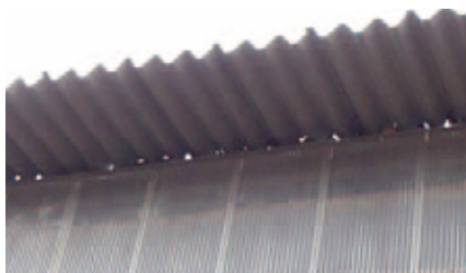
腐食（いたる所に穴の空いた折板ルーフデッキ）
