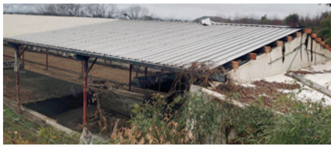
腐食したる所に穴の開いたガルバニウム屋根
