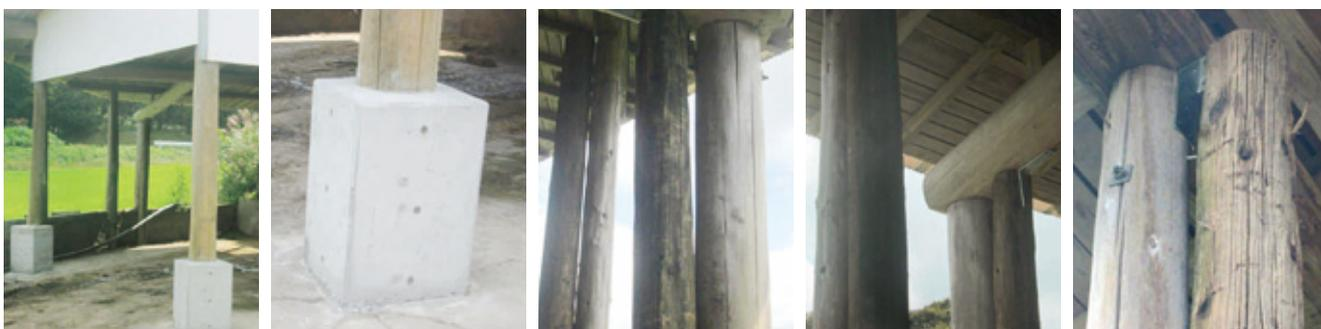
腐植した木造柱をコンクリート巻補強 & 2本柱補強
