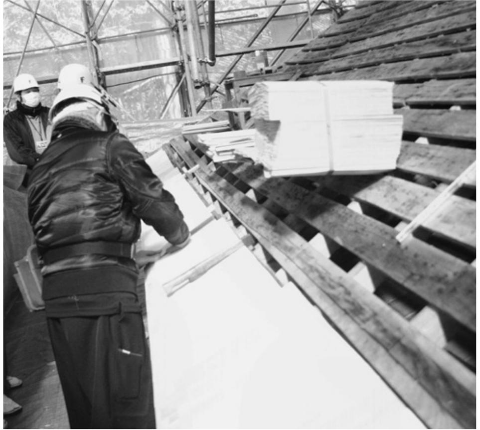
屋根葺き替え(柿葺き)作業のようす
