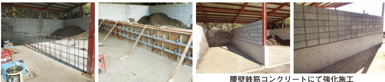
腰壁鉄筋コンクリートにて強化施工
