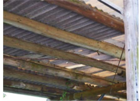
雨漏りの激しい堆肥舎屋根
