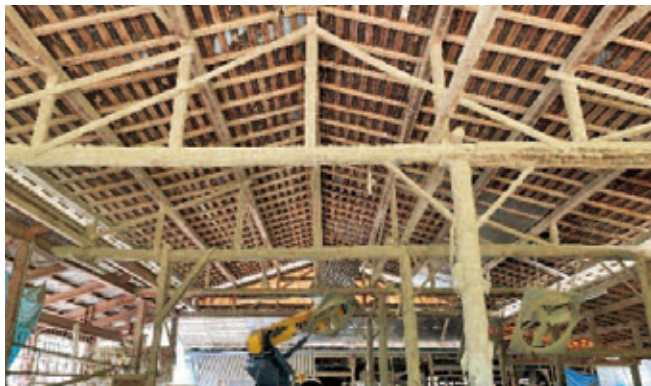
写真3 施工前の屋根裏のようす
