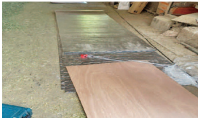
写真4 遮断熱シートを裁断
