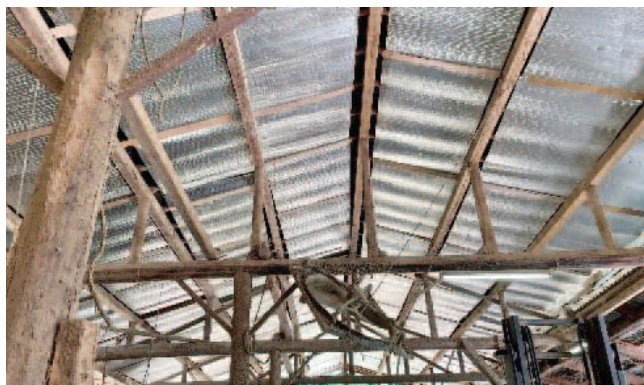
写真8 施工後の屋根裏のようす
