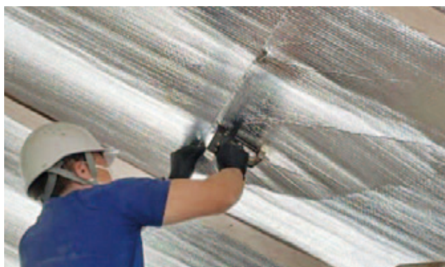
写真6 遮断熱シートをタッカーで仮止め
